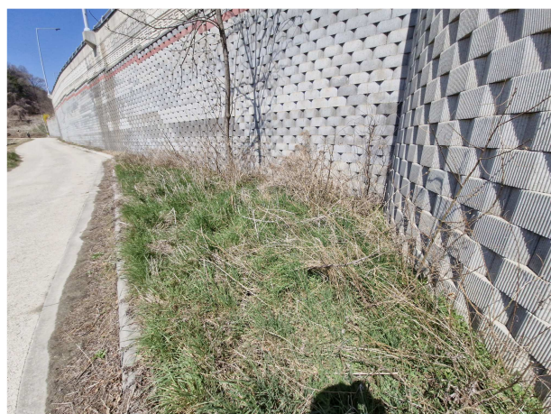
기초, 지반부 전경
