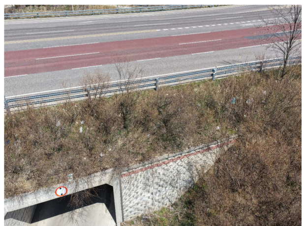
옹벽 상단 사면 전경
